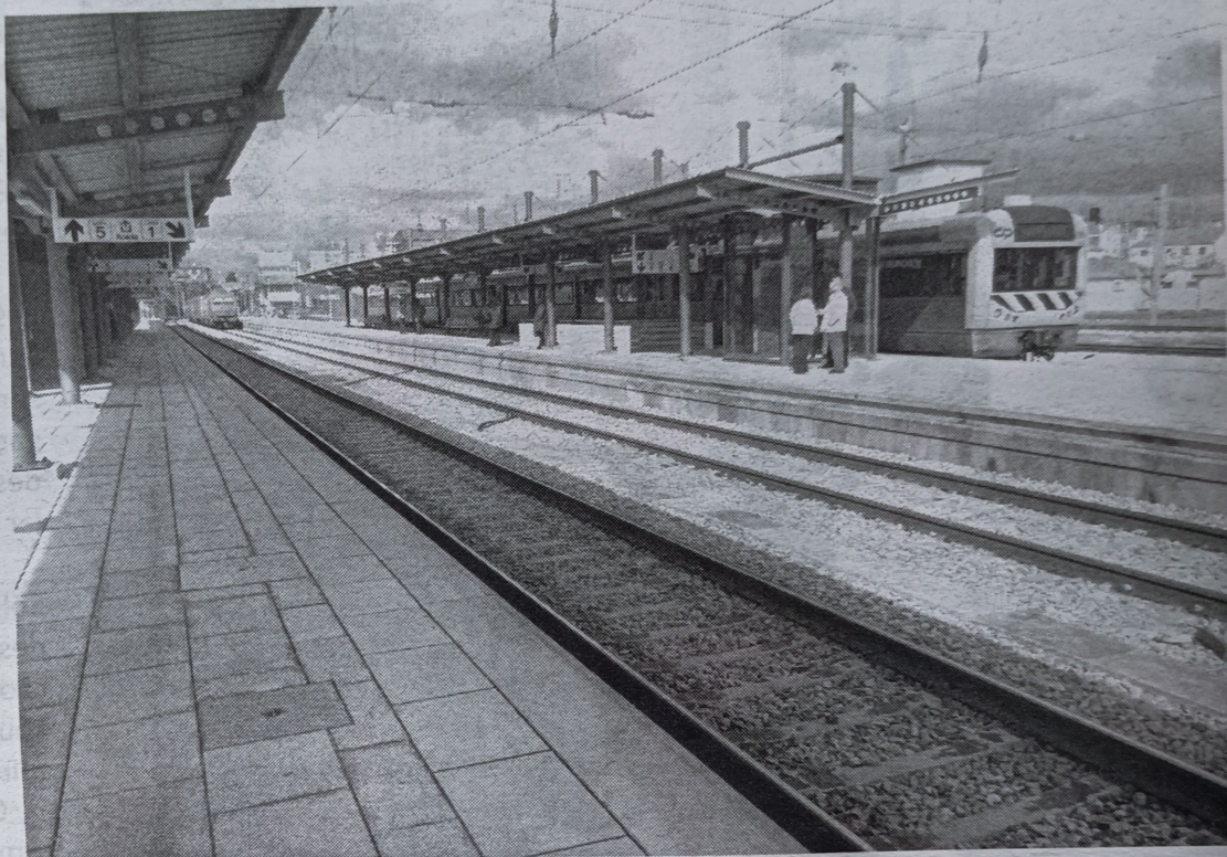
A Linha da Beira Alta foi encerrada para obras de modernização em 19 de Abril de 2022
